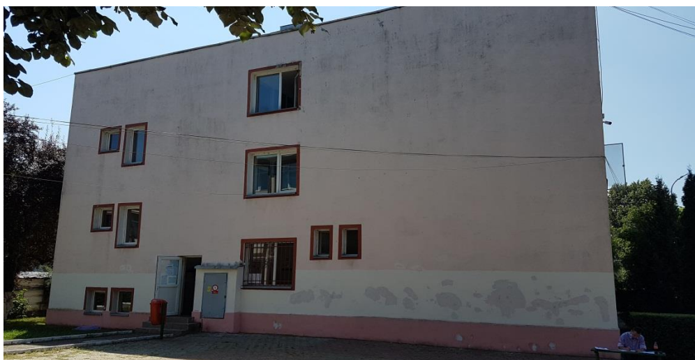
Figura 1 – Fațada principală NORD
